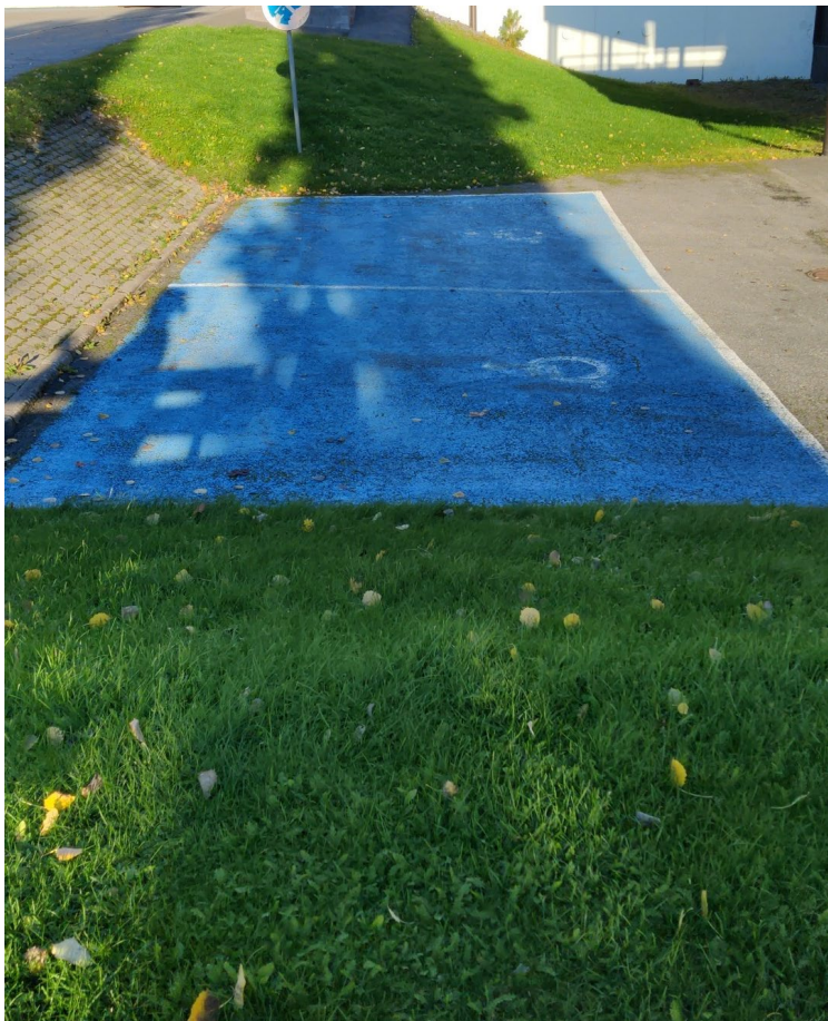
Pystyopaste puuttuu
