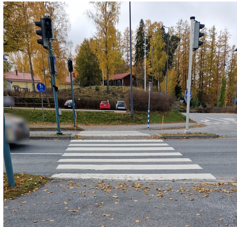
Keskisaarekkeen liikennevalopainike vaikeasti saavutettavissa
