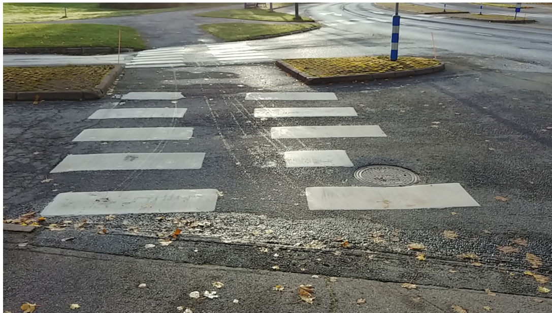
Asfaltoitu loivennus
