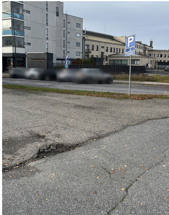
Rajaviivat ja pintaan maalattu opaste puuttuvat
