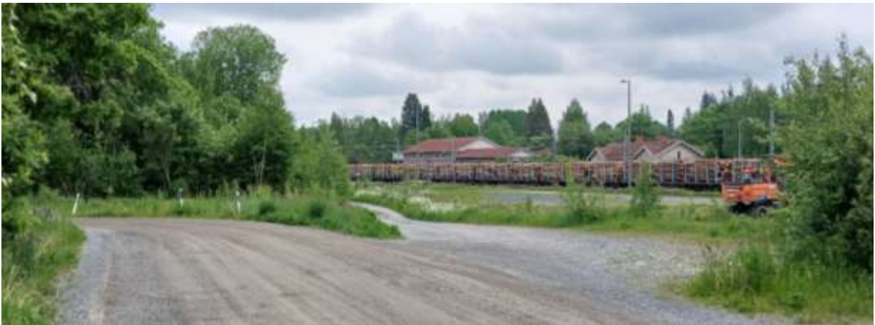
Kuva 3 Näkymä pohjoispuolen Veturitallinkadulta kohti kaavoitusaluetta ja rautatiekiskoja. Taustalla näkyvät Asemakatu 23 rakennukset. (Maankäyttö, elokuu 2025).
