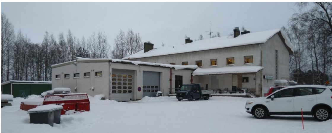
Kuvat 11-13: Meijeri on rakennettu vuonna 1951. Laajennusosa eli maidon vastaanottohalli on rakennettu vuonna 1978. Meijeri kuuluu Vammalan keskustan maakunnallisesti merkittävään rakennettuun kulttuuriympäristöön.
