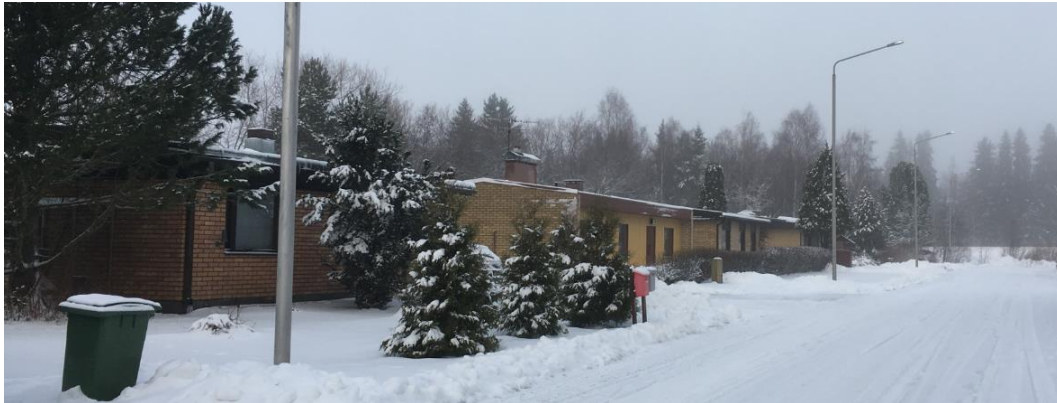
Kuva: 6 Sumakatu on rakentunut 1970- luvulla.
