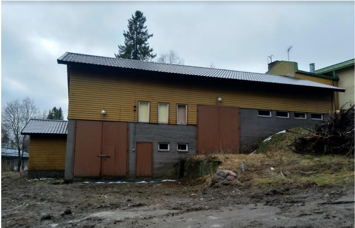
Kuva 21: Kaupparakennuksen varastosiiپی. Kuva otettu 2019.
