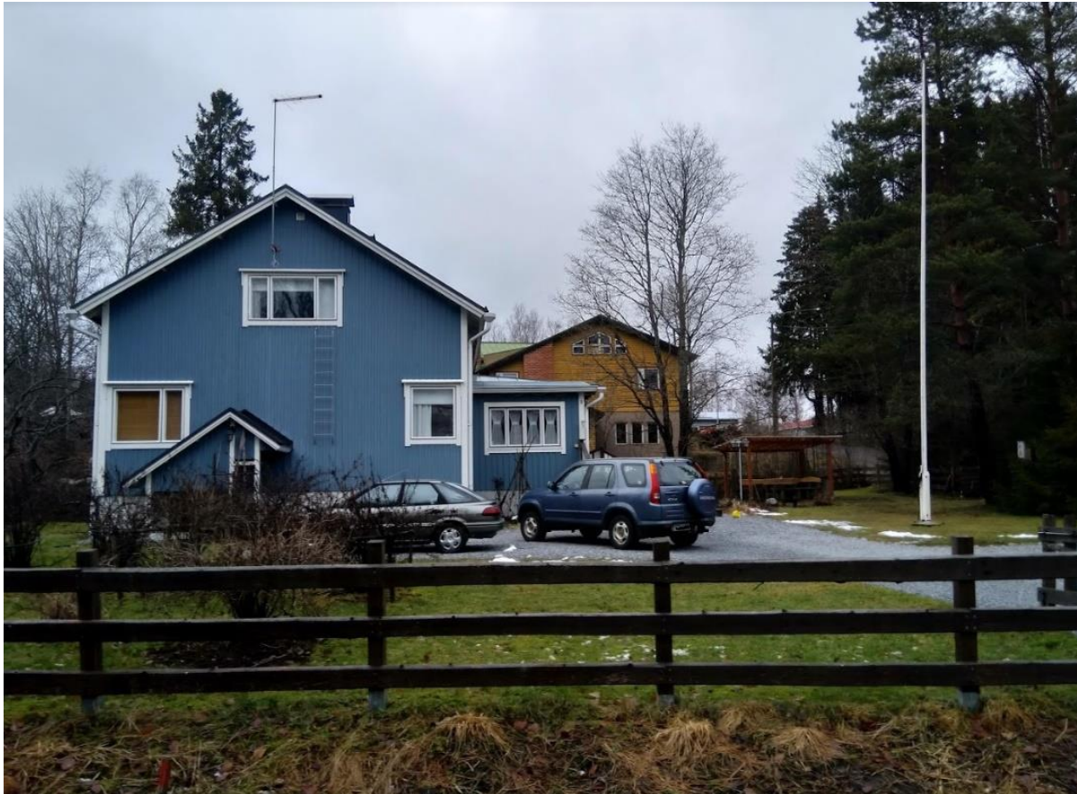
Kuva 22: Asuinpientalo, rakennettu 1952. Kuva otettu 2019.
