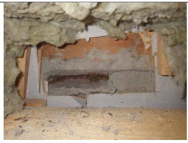
Kuva 47 – Yleiskuva, hirren saumassa tiivisteenä savea, [US7]
