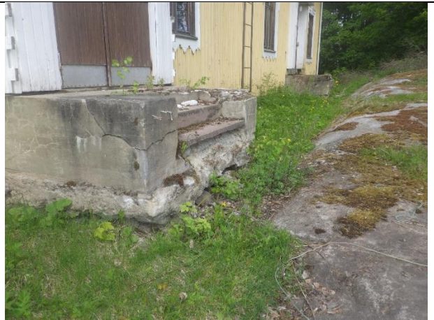
Kuva 4 – Kallioleikkaus kaataa rakennusta kohden
