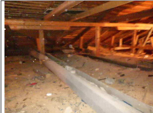
Kuva 62 – Yläpohjassa olevaa täyttöä
