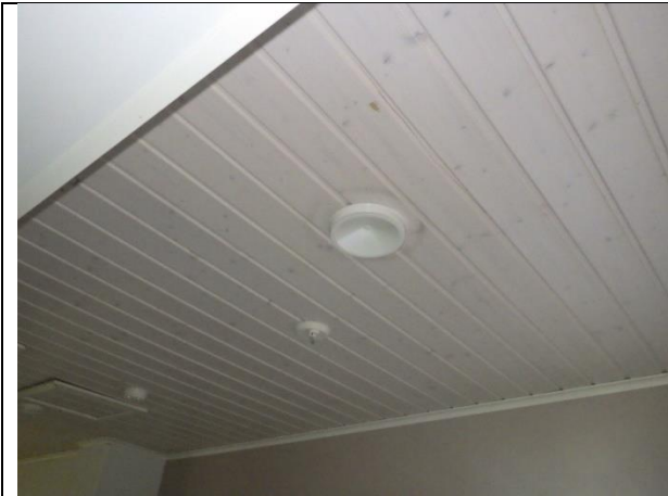
Kuva 68 – Ilmanvaihdon päätelaitteita
