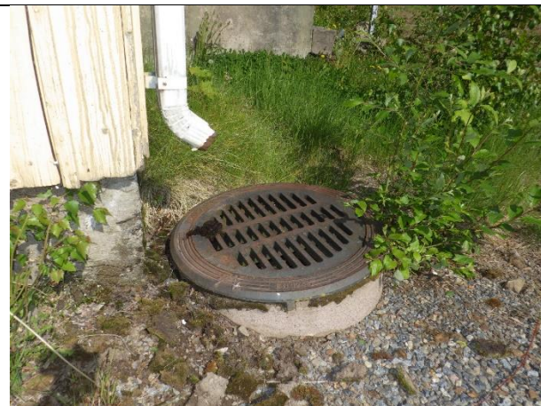
Kuva 7 – Kattovesien ohjausta
