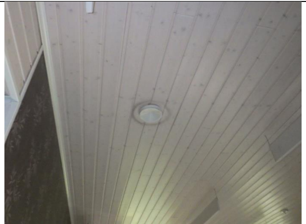
Kuva 69 – Ilmanvaihdon päätelaitteita
