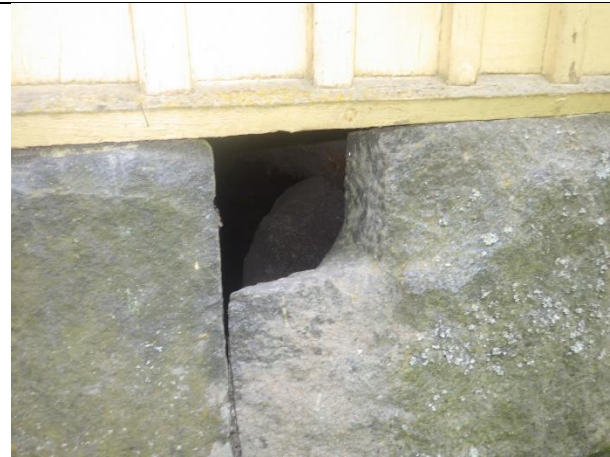
Kuva 24 – Alapohjan tuuletusluukku.
