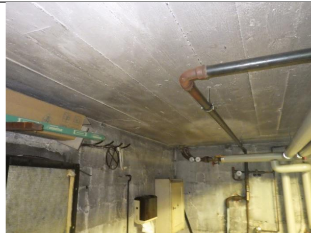
Kuva 53 - Yleiskuva, rakenne alapuolelta [VP1]
