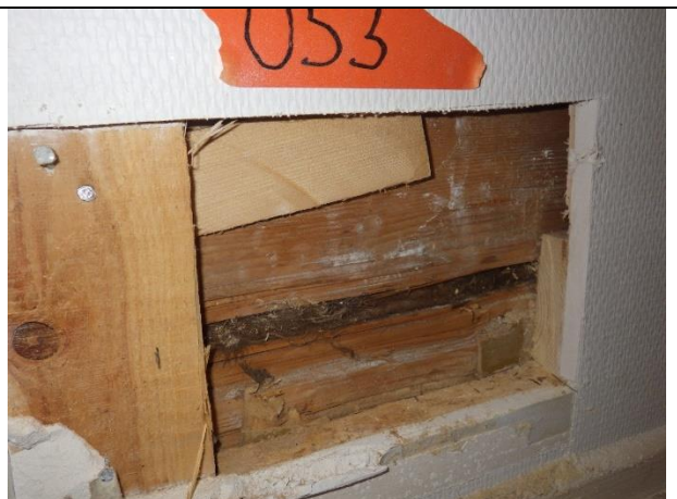
Kuva 43 - Yleiskuva, ei sisäpuolista lämmöneristettä, [US3]
