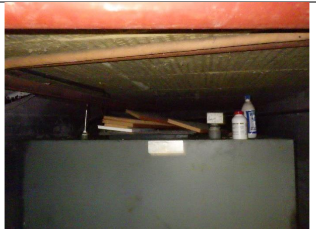
Kuva 54 - Yleiskuva, rakenne alapuolelta [VP1]
