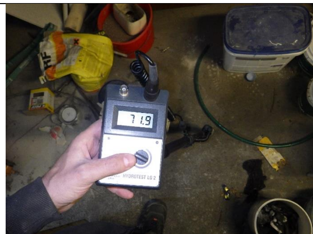
Kuva 28 – Maanvastaisessa betonirakenteessa ei havaittavissa selkeitä poikkeamia
