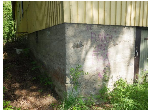
Kuva 5 – Teräsbetonirakenteista sokkeliä
