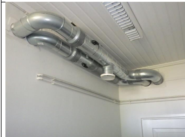
Kuva 66 – Tulo- / poistokanavistoa
