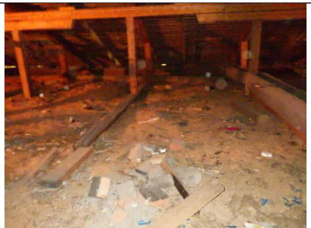
Kuva 61 – Yläpohjassa olevaa täyttöä
