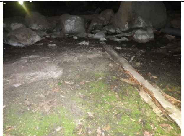
Kuva 27 – Kallion pinta osittain havaittavissa.
