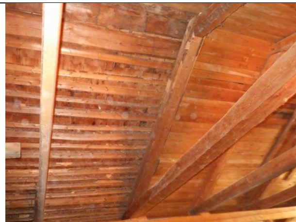
Kuva 60 – Yläpohjassa laajennusosa havaittavissa
