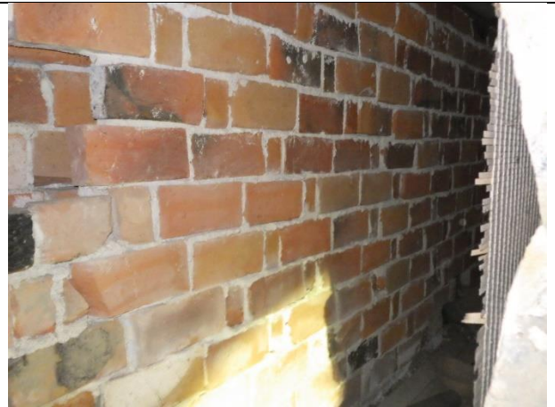
Kuva 25 – Kellarin seinää alapohjan puolelta.
