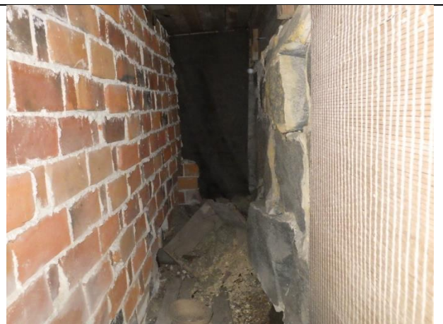
Kuva 34 – Kellarin seinärakenteen toteutusta ryömintätilan puolelta
