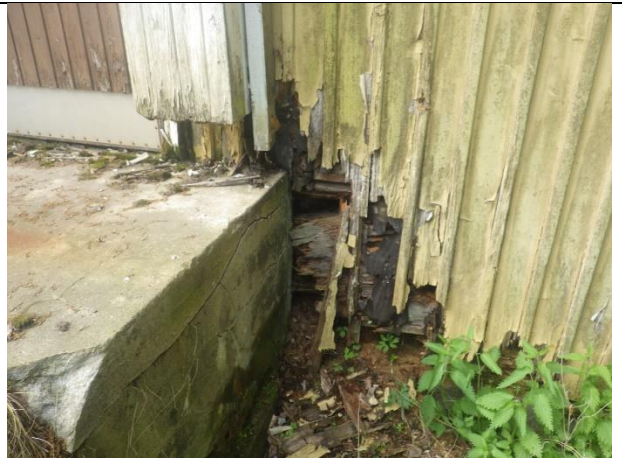
Kuva 39 – Hirsirungon lahovaurioita
