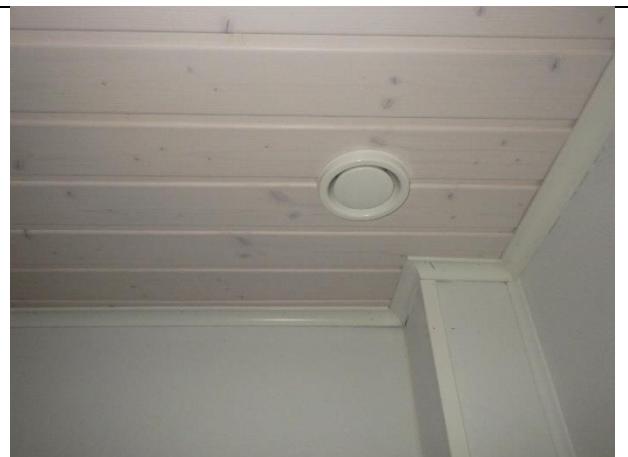
Kuva 67 – Ilmanvaihdon päätelaitteita
