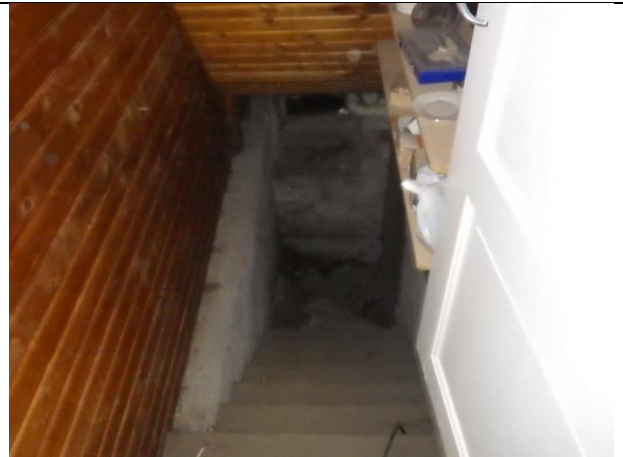
Kuva 36 – Kellariin johtavat portaat sisätiloista
