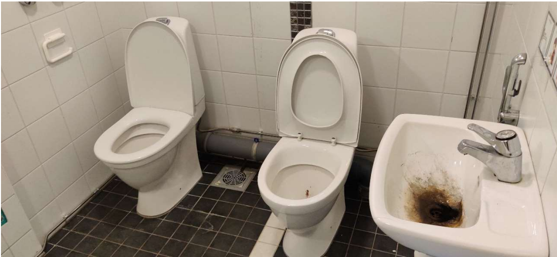
Kuva 19. Wc-tiloissa on päiväkotiin sopivia tilajärjestelyjä.
