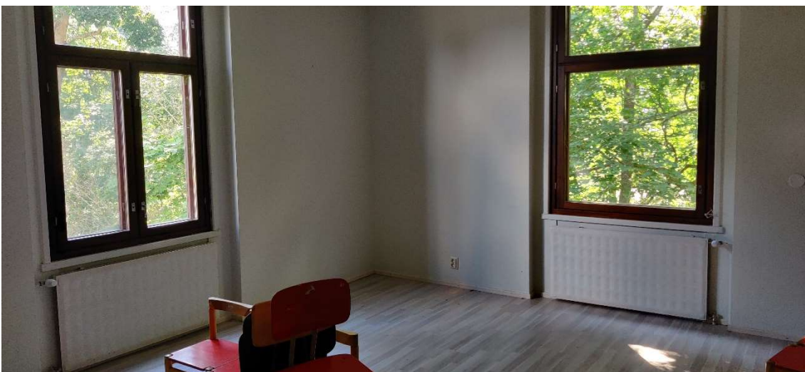
Kuva 17. Huone eteläpäädyssä. Ikkunoiden alla vesikiertoiset patterit.
