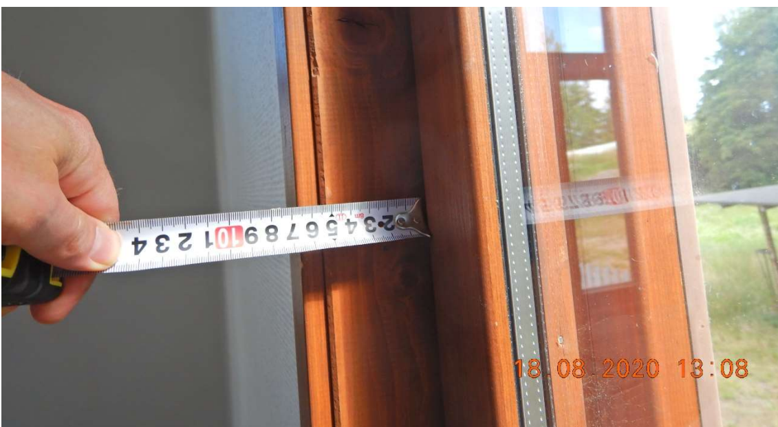
Kuva 15. Ikkunoiden sisämyygi voi viitata siihen, että ulkoseiniä on lisälämmöneristetty sisäpuolelta.
