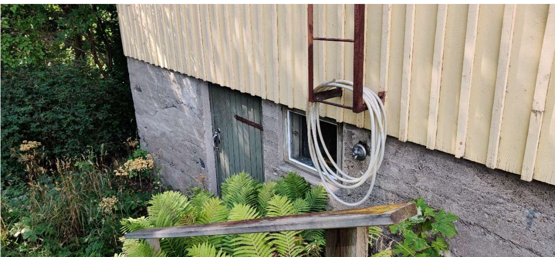
Kuva 11. Eteläpäädyssä on sisäänkäynti kellarikerroksen kattilahuoneeseen.
