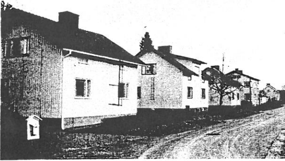
Lizeliuksenkatu, pääosin 1940-luvun loppupuoli
