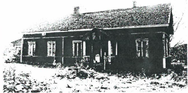
vanha asuinrakennus (1) koillisesta
