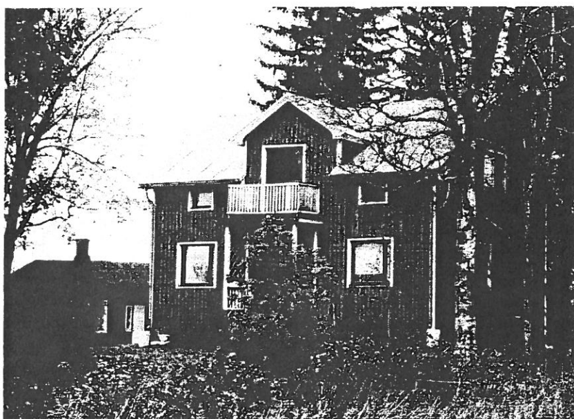
talousrakennus ja asuinrakennus
