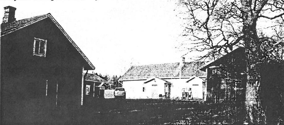
Nuutilan pihapiiri kaakosta, navetta, vanha asuinrakennus, asuinrakennus ja aitta/varastorakennus
