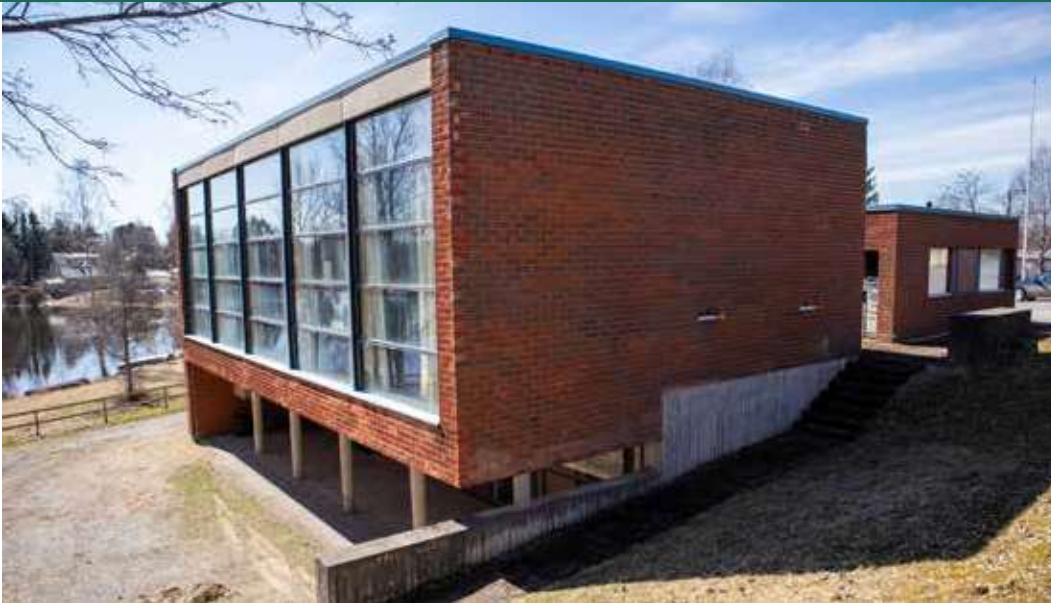
Kiikan seurakuntatalo, julkisivu koillisesta. Kuva: Kerttu Loukusa 2022.
