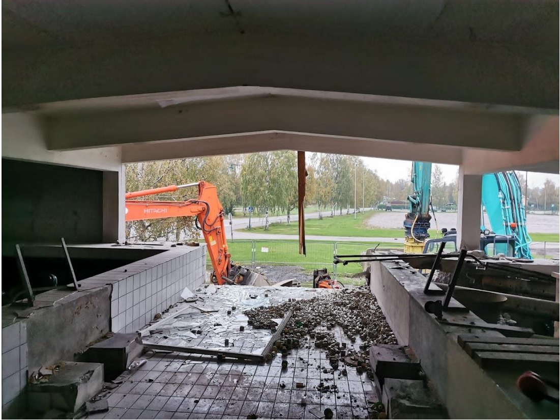
Kilpinokan vedenottamon purkutyömaa syksyllä 2023. Kuva: Raimo Luomala
