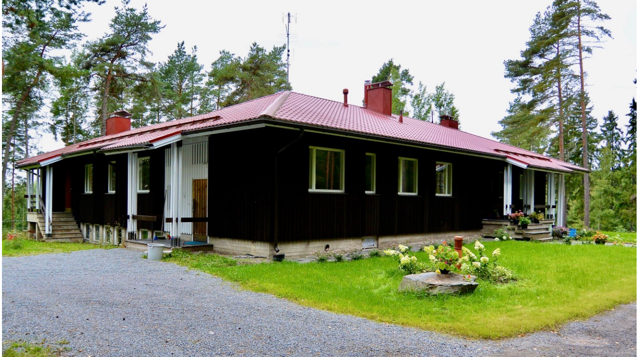
Kuva 4: Päärakennus kuvattuna Karhunpolulta suunnasta, mahdollinen autotalli tulisi kuvan vasemmalle puolelle (kuva: Jukka Laiho)
