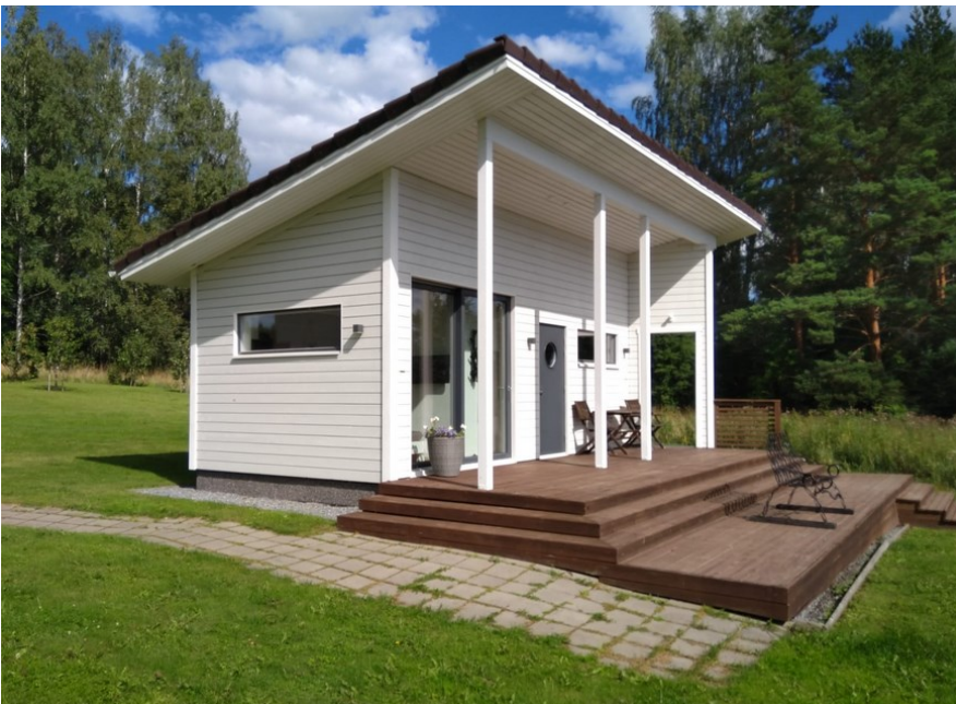
Kuva 8: 2014 vuonna rakennettu saunarakennus.
