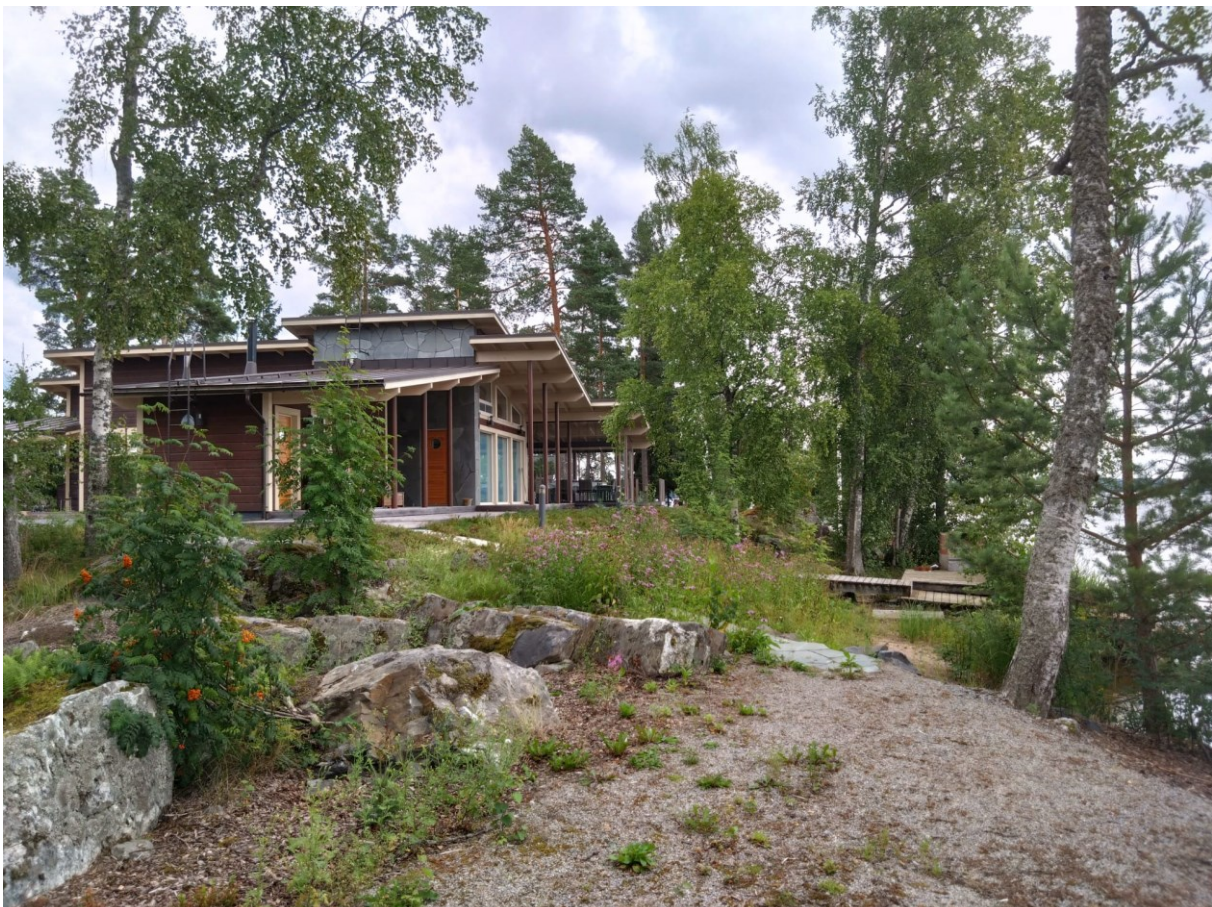
Kuvat 5 ja 6: Ylempi näkymä kohti sisäpihaa luoteesta katsottuna ja näkymä saunarakennuksen lounaispuolelle.
