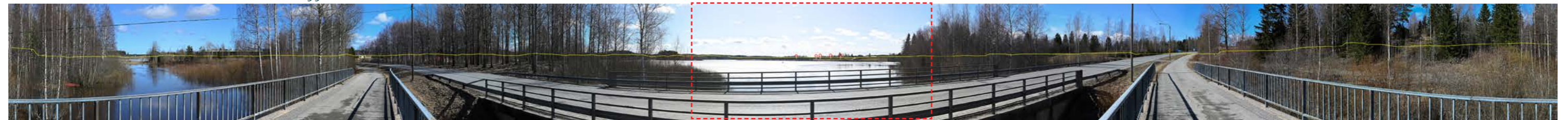
Valokuvasoivite kuvauspisteestä 1, voimalasijoittelu VE2 mukainen. Punaisella katkoviivalla merkitty alue on suurennettuna yllä olevassa kuvassa. Keltainen viiva esittää suuntaa-antavasti maastonmuotoja kuvan horisontin alueella. Punaiset ympyrät kuvaavat voimalan roottorin halkaisijaa.
