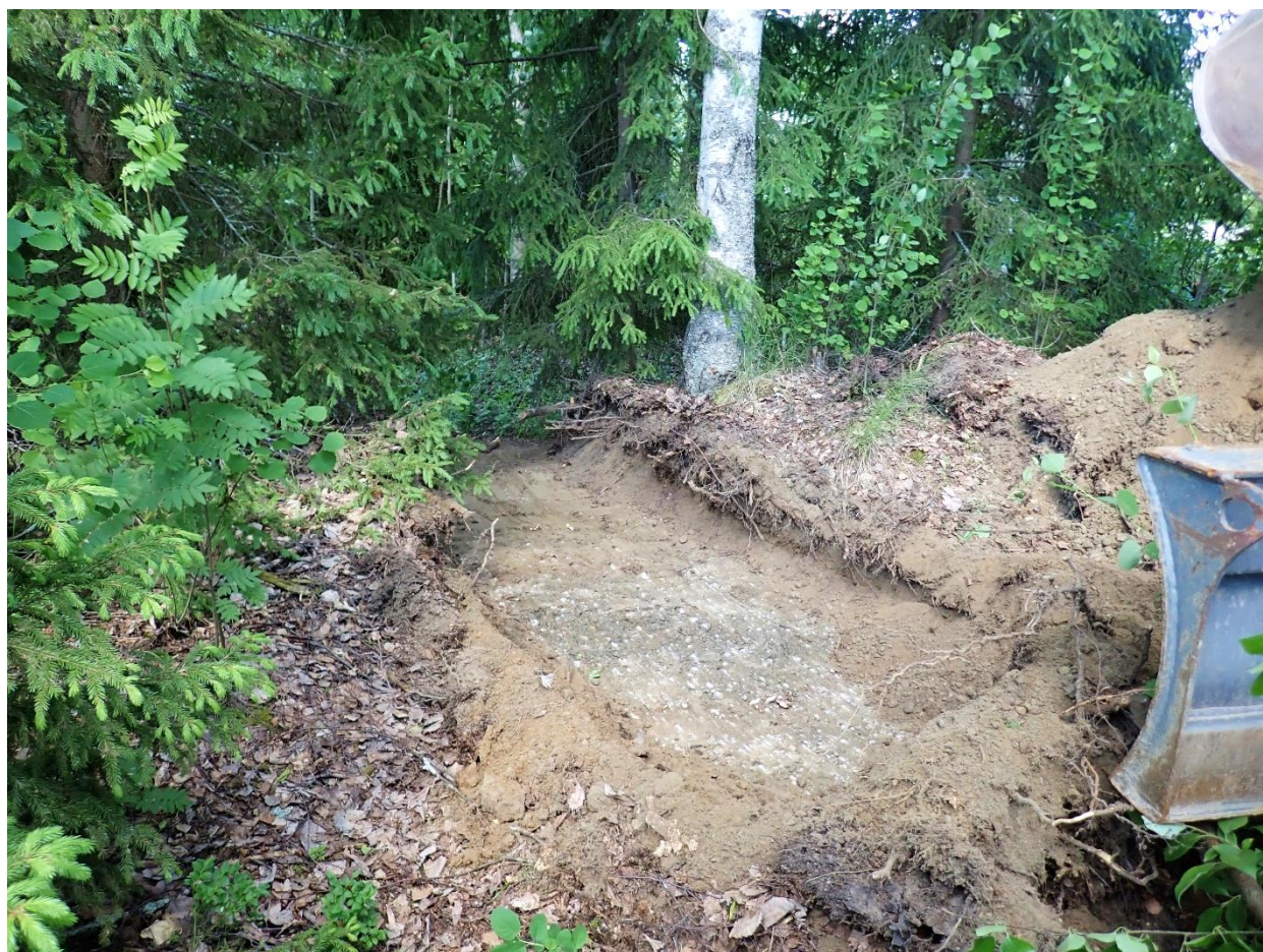
Kuva 36. Koeojan 1 pintakerroksen alta paljastunutta asfalttia tai öljysoraa. Kuvattu etelästä. Kuva: Siiri Tuomenoja, Maanala Oy.
