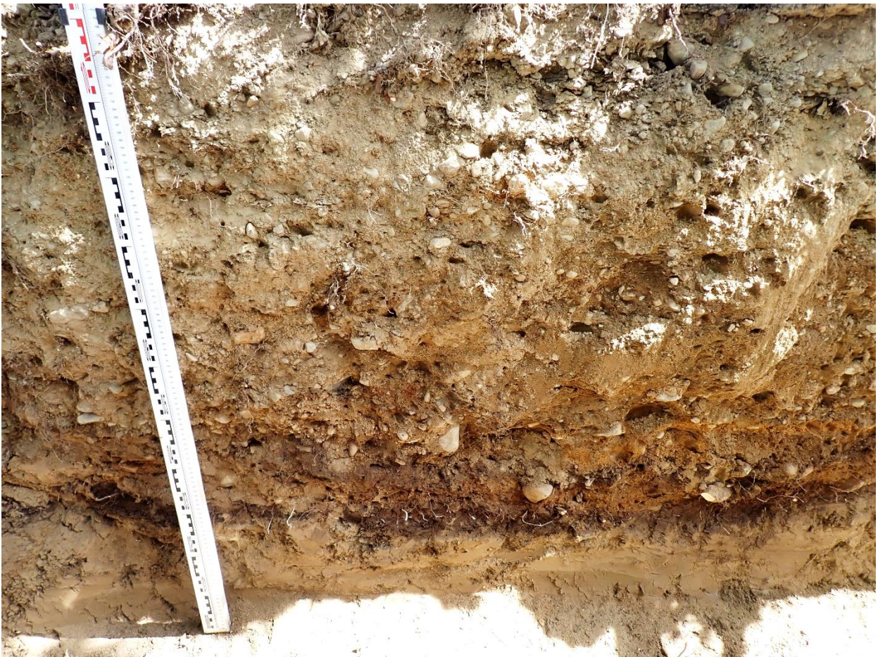
Kuva 60. Koeojan 3 itä/koillisleikkausta. Puhtaan pohjasaven päällä on tummana juovana tien vanhin säilynyt käyttökerros. Sen päällä on modernin tien perustamiskerroksia, lähinnä hiekka- ja soramaata. Kuva: Siiri Tuomenoja, Maanala Oy.
