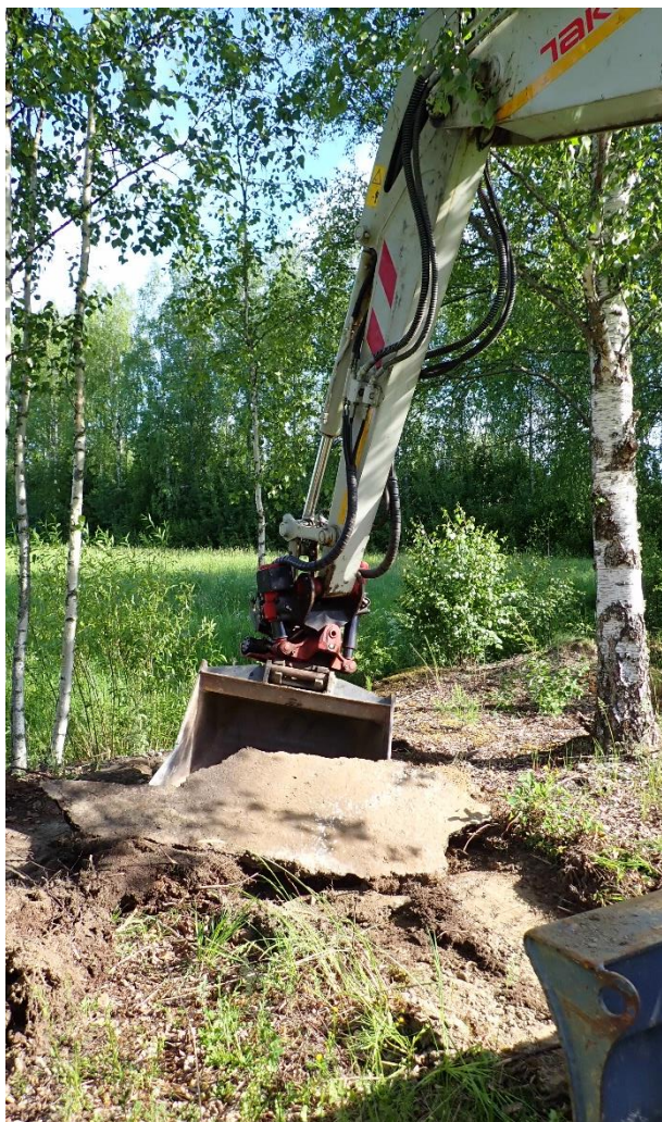
Kuva 55. Koeojan 3 pohjoispäädystä nostetaan hyvin säilynyttä asfaltti- tai öljysora-päällystekerrosta. Kuvattu koilliseen. Kuva: Siiri Tuomenoja, Maanala Oy.
