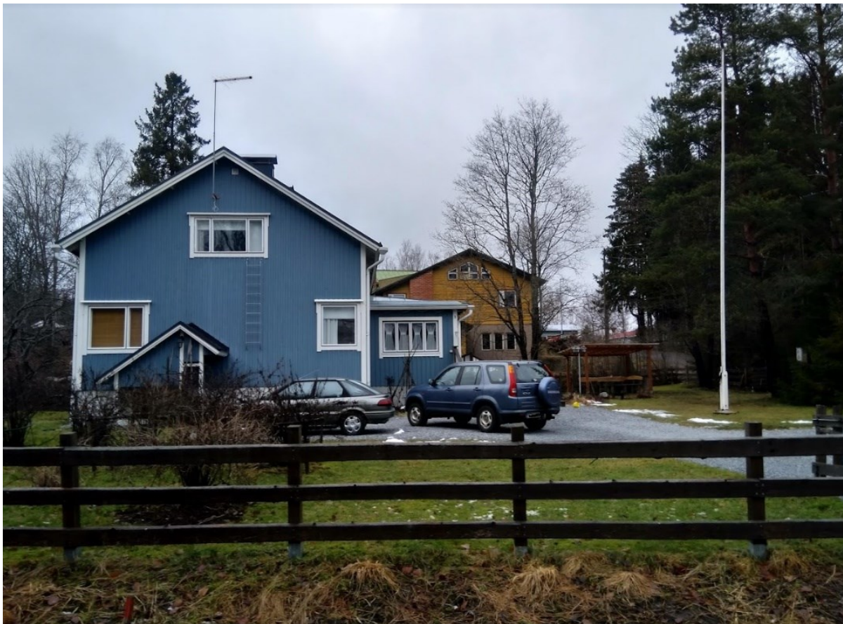
Kuva 22: Asuinpientalo, rakennettu 1952. Kuva otettu 2019.
