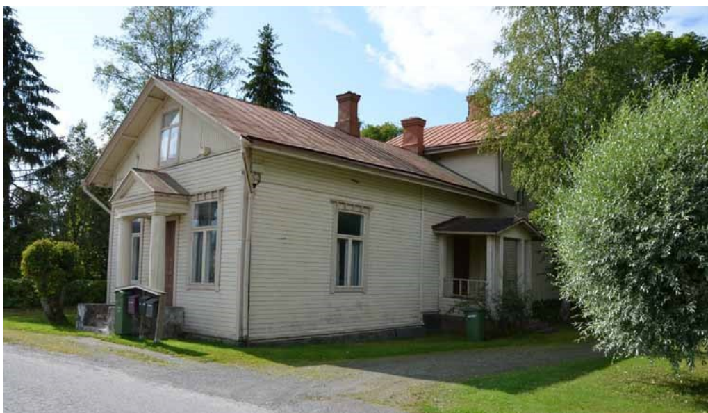
Kuva 19: Vanha lakkitehdas, johon kaavakartalla viitataan Hovin asuin- ja liikerakennuksena. Vanhat osat on rakennettu 1910/20. Kuvassa piilossa oleva matala asuinosa on rakennettu 1970. (kuva: Jari Heiskanen 2019)
