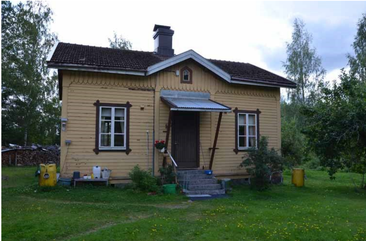
Kuva 17: Kaksoisvahtituvan (tyyppi 2) piirustuksilla 1895 rakennettu asuinrakennus (kuva: Jari Heiskanen 2019)
