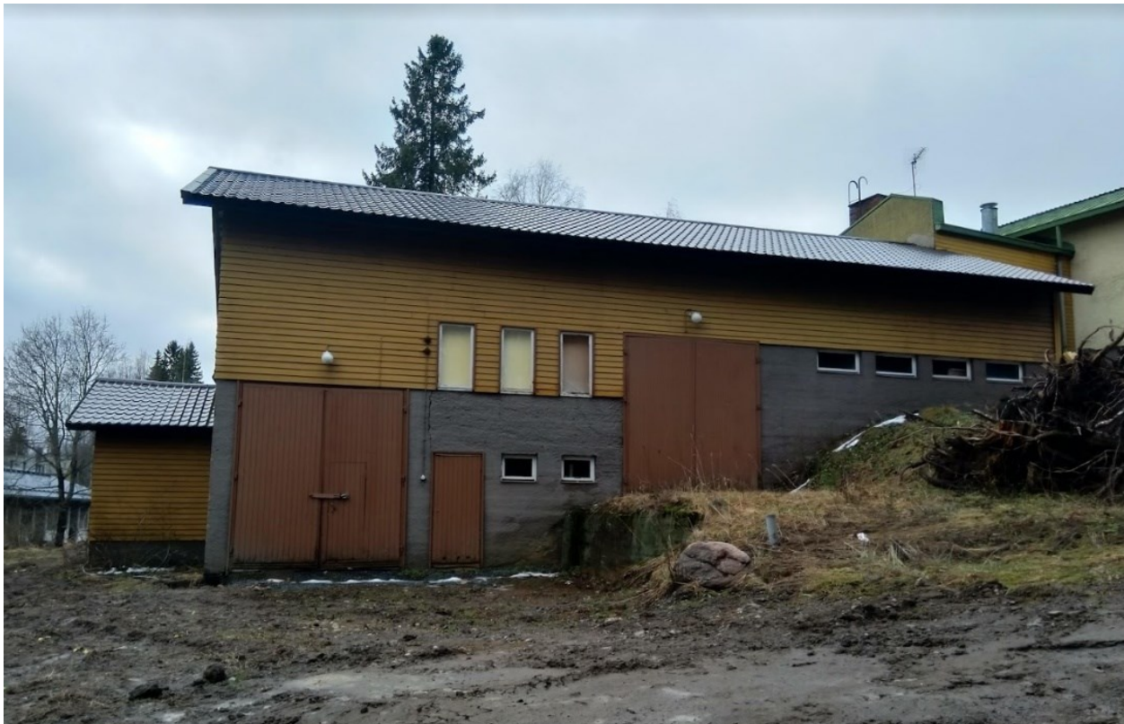
Kuva 21: Kaupparakennuksen varastosiipi. Kuva otettu 2019.
