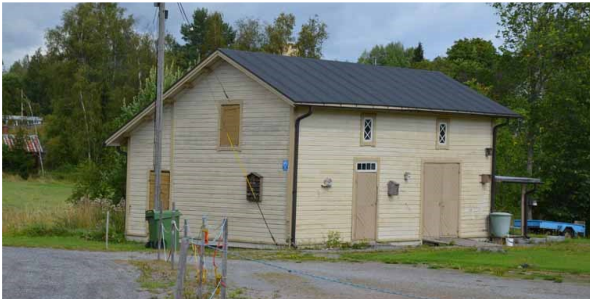
Kuvat 15 ja 16: Ylemmässä kuvassa asemarakennus, vasen pääty rakennettu 1895 ja oikea pääty jatkettu 1904. Alemmassa kuvassa aseman talousrakennus, rakennettu 1895. (kuvat: Jari Heiskanen)
