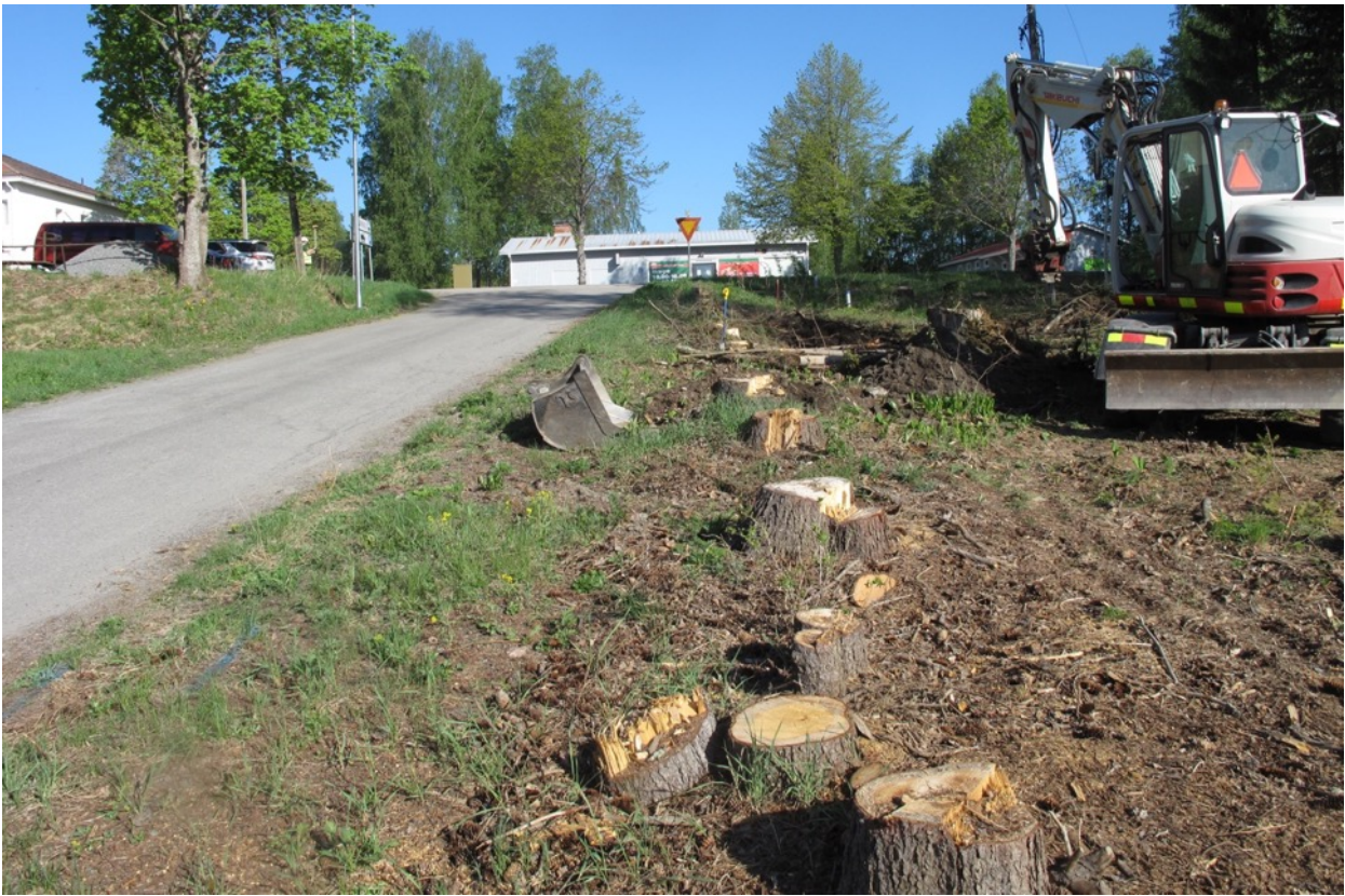
Kuva 22. Asemantietä pohjoiseen. Kaadetun kuusiaidan kannot tien reunalla. Kuva Hannu Takala, Maanala Oy.
