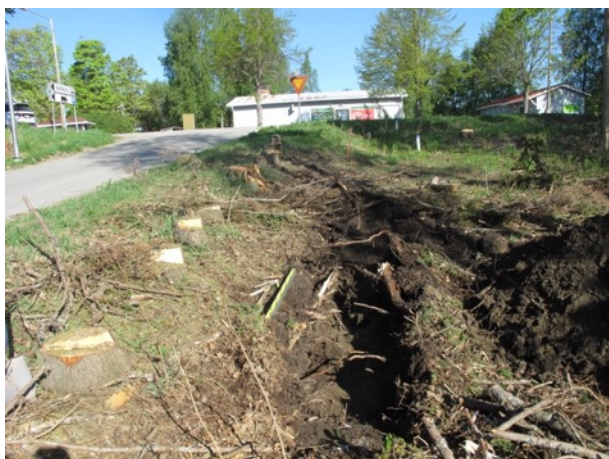
Kuva 42. Koekuoppa nro 9, kuva etelästä.
