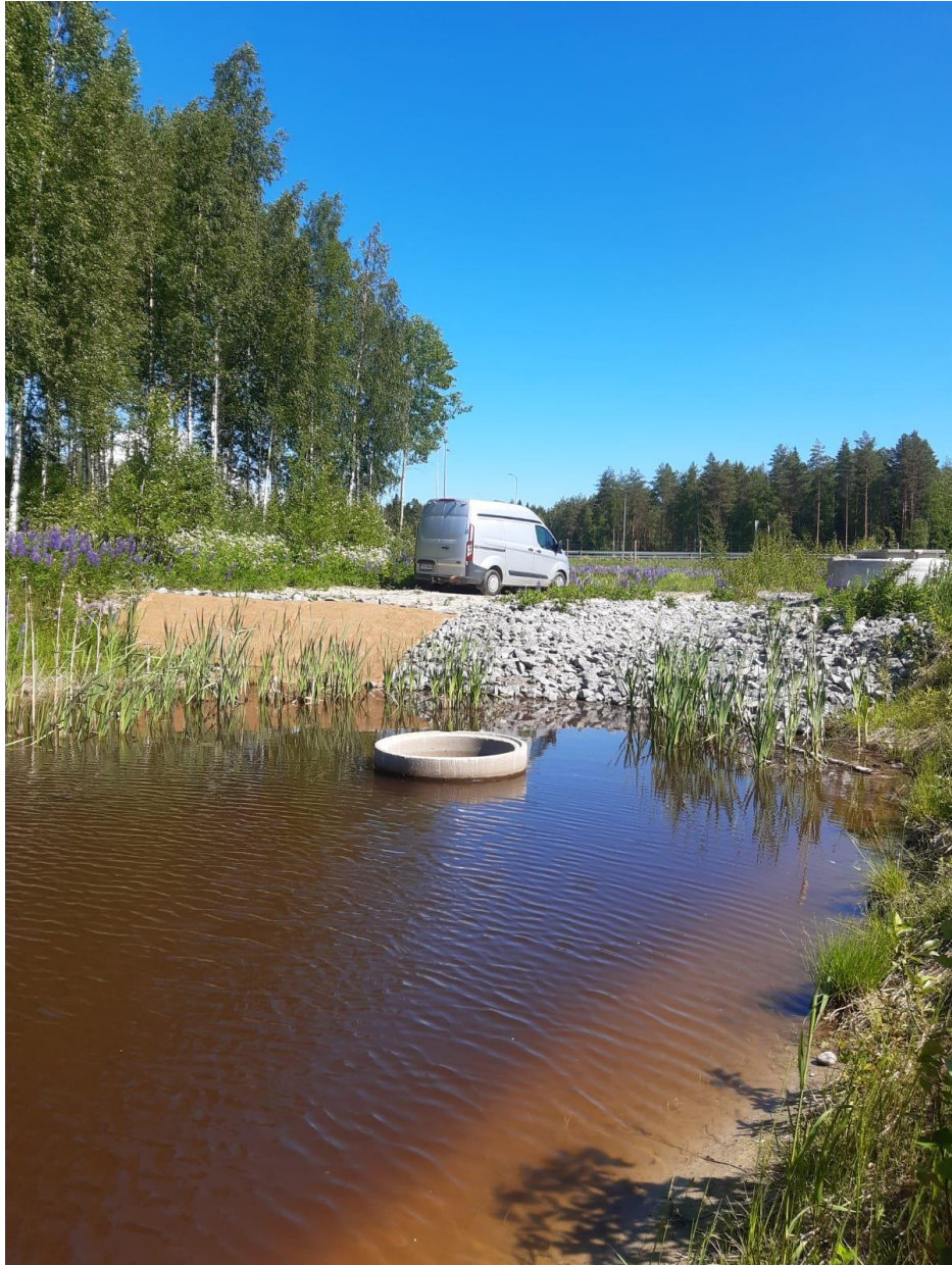
Huleveden viivästysallas kesällä 2024. Kuva: Markku Viitaniemi
