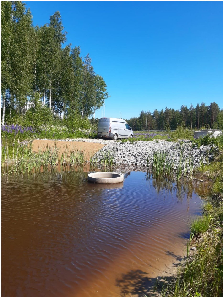
Huleveden viivästysallas kesällä 2024. Kuva: Markku Viitaniemi
