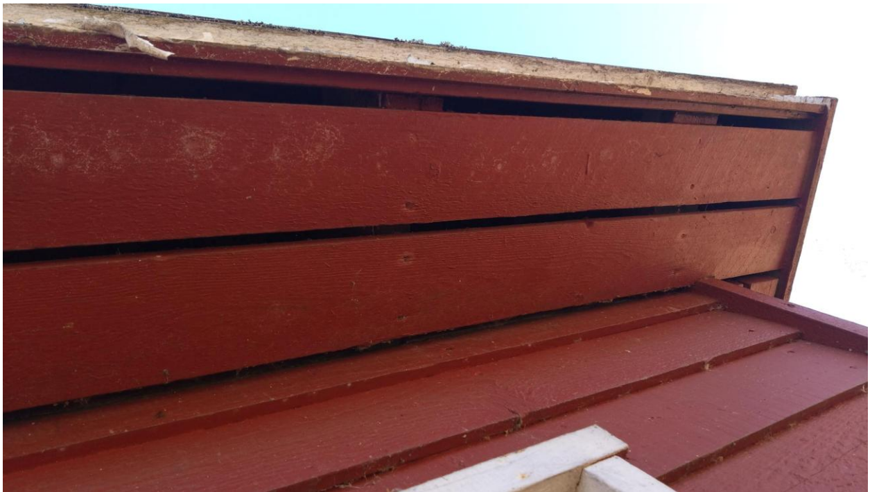
Kuva 2. Räystäään rakenne vaikuttaa erittäin sopivalta lepakoille.
