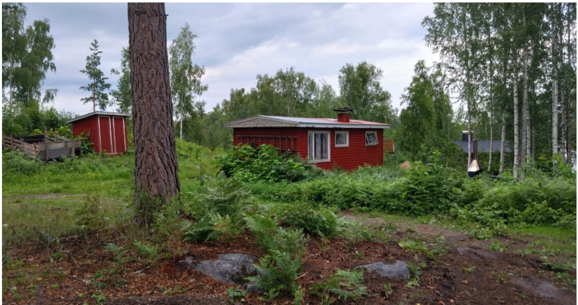
Kuva 11 Jassalantie 96 kiinteistöllä sijaitseva jalasmökki etualalla. Kesä 2024.
