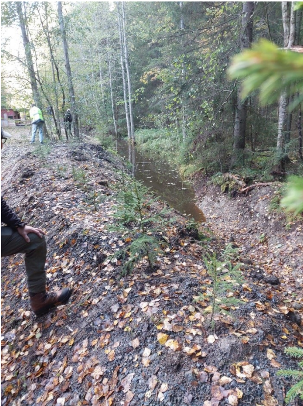
Kuva 1. Ulkopuolisten vesien hallinta; haihdutusallas ja maavalli
