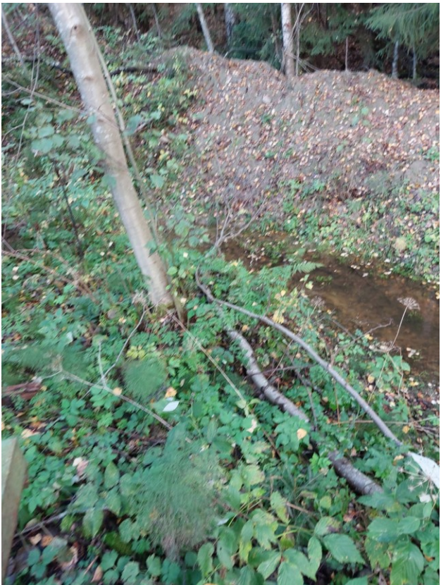
Kuva 6. Sisäpuolisten vesien hallinta; maavalli
