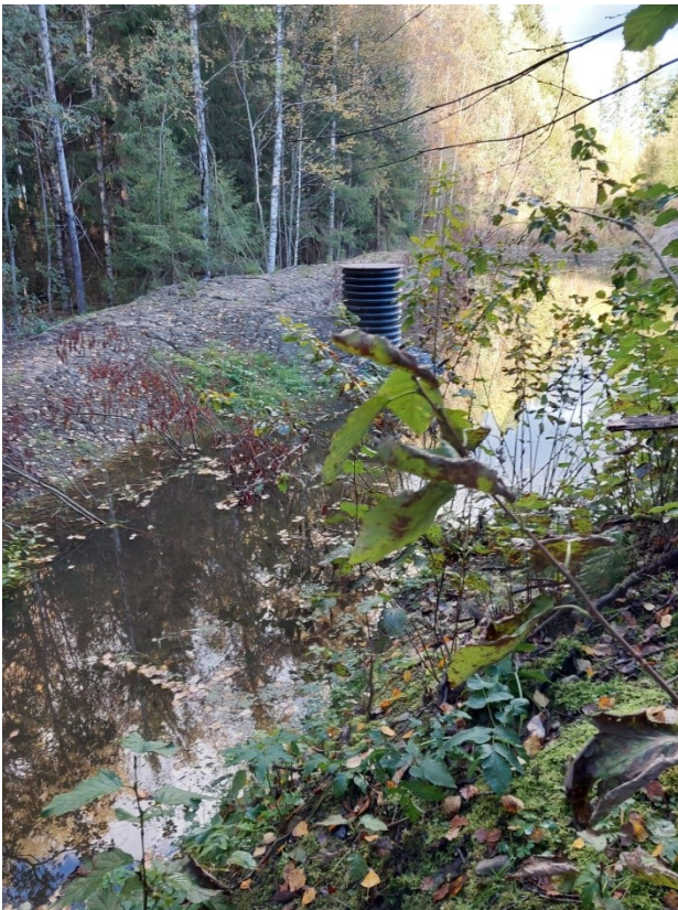
Kuva 5. Sisäpuolisten vesien hallinta; maavalli
