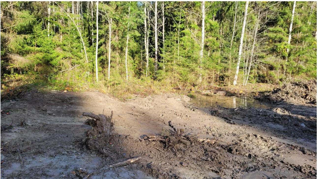
Kuva 5. Pintamaa poistettu. Maaperä pääosin savea.
