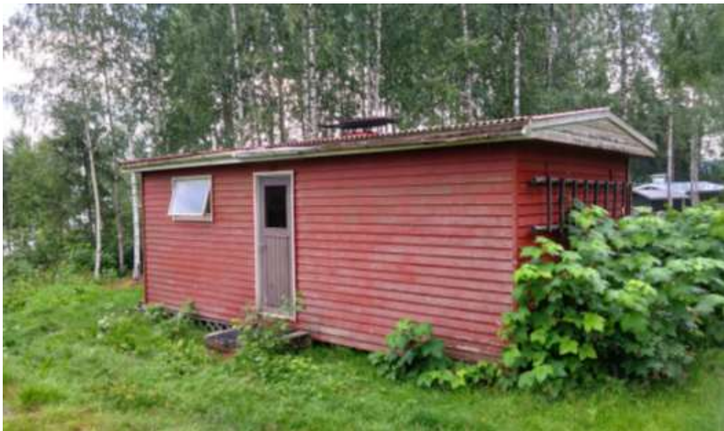
Kuva 12 Jassalantie 96 kiinteistöllä sijaitseva jalasmökki toisesta suunnasta. Kesä 2024.
