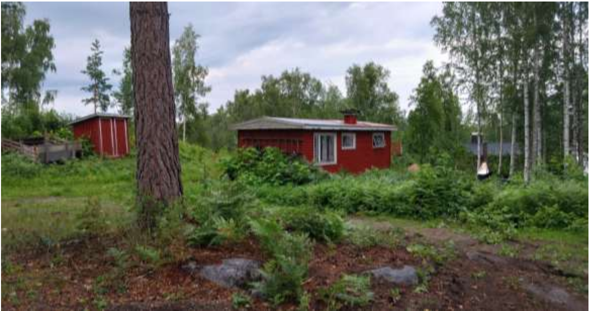
Kuva 11 Jassalantie 96 kiinteistöllä sijaitseva jalasmökki etualalla. Kesä 2024.
